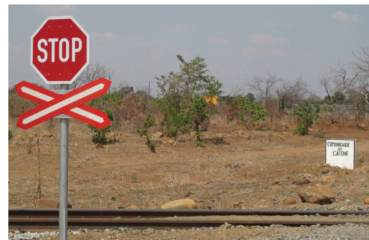
Estrada de Ferro no Reassentamento de Cateme
