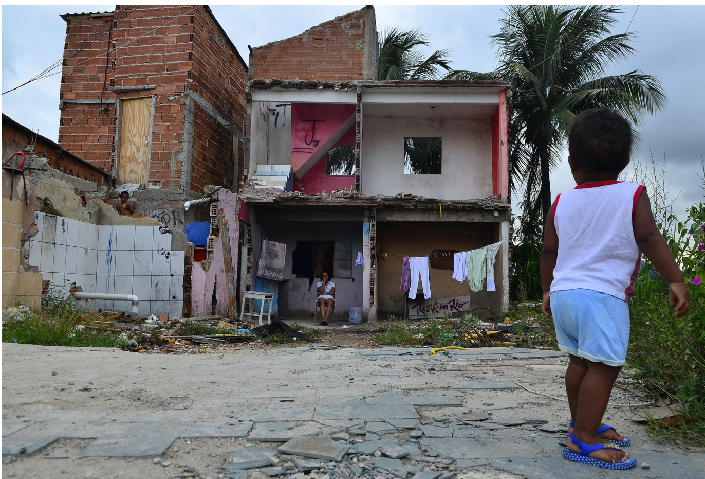
Menino observa uma casa que foi parcialmente derrubada na Vila Autódromo, no Rio. Foto: Fernando Brazão / Agência Brasil
